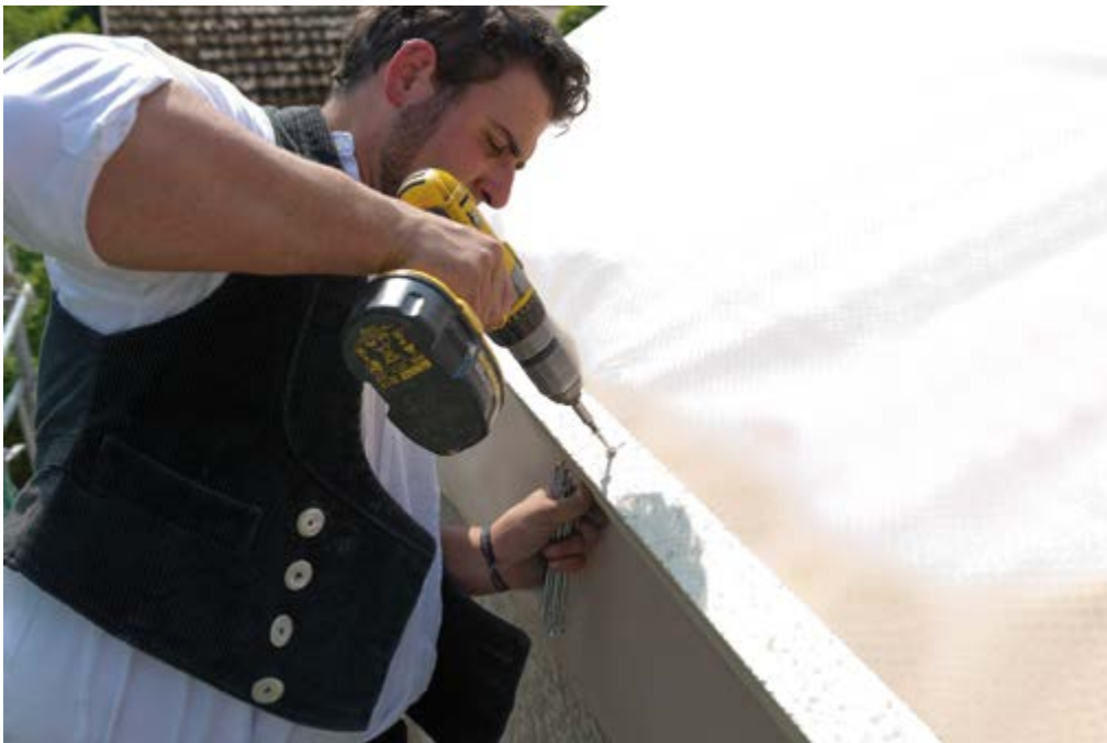
Die Traufbohle aus recyceltem Polyurethan ist feuchteresistent und dämmt besser als Holz.
