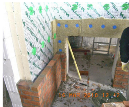
Abb. 2: Steinwolle im Luftspalt zw. Dämmung und Vorsatzschale
