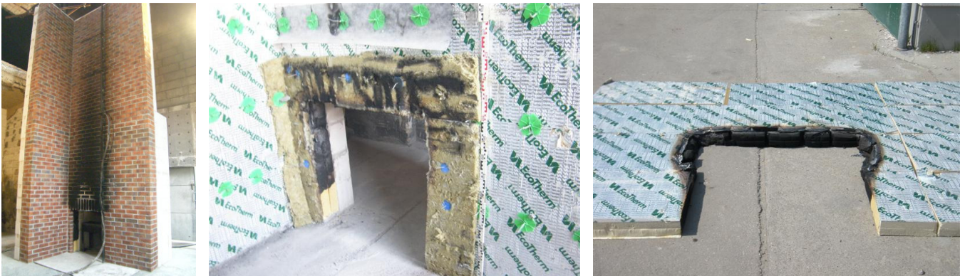
Abb. 14 bis 16: Zustand des Prüfkörper nach dem Versuch
