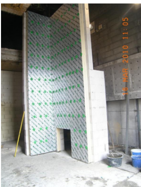
Abb. 1: applizierte Dämmung
