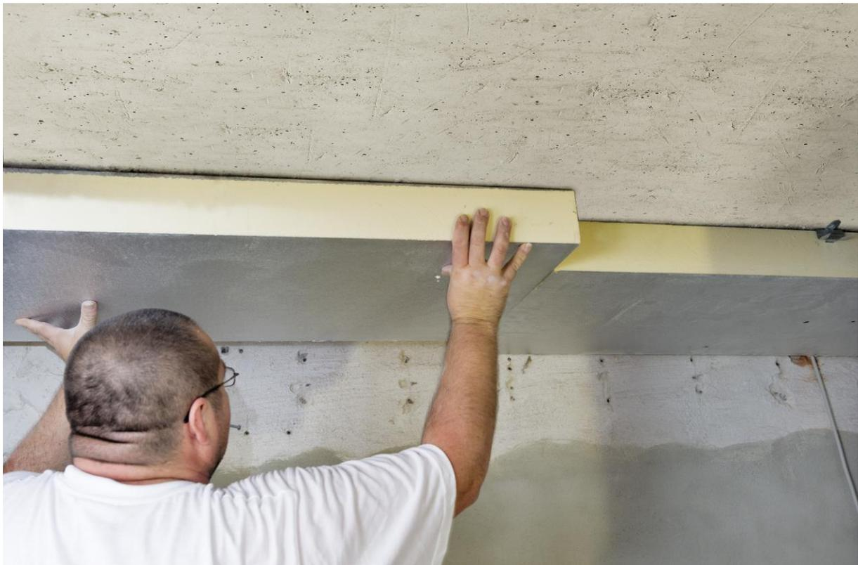
Nie mehr kalte Böden im Erdgeschoß: Eine PU-Dämmung an der Kellerdecke kann man wetterunabhängig jederzeit einbauen.
