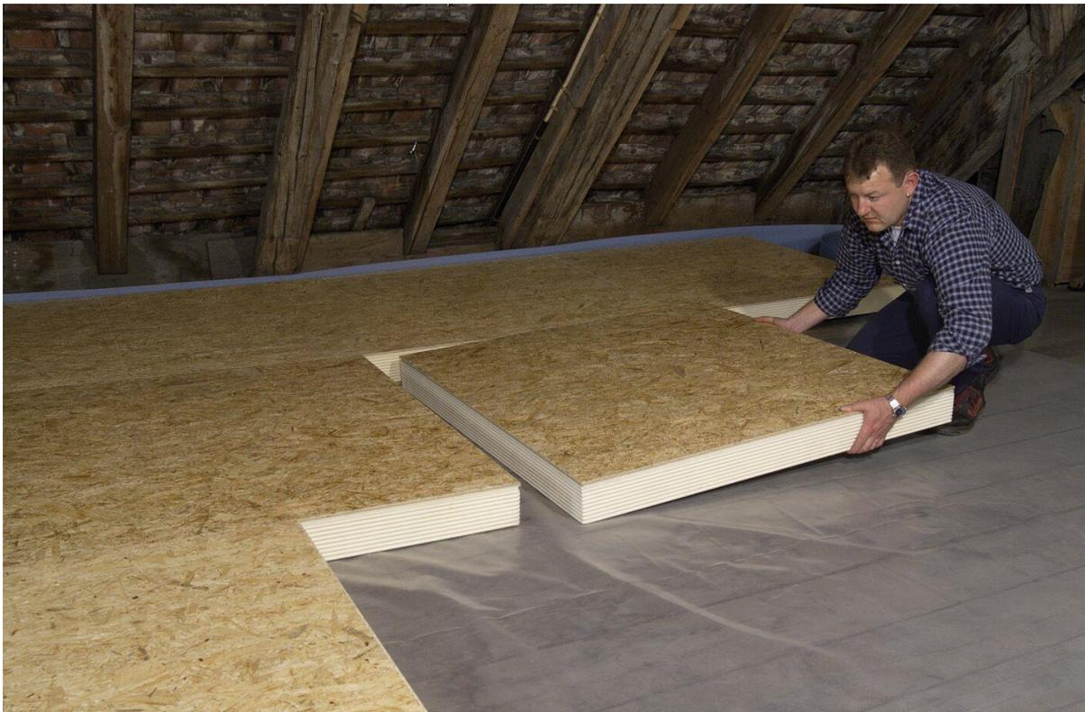
Dachräume mit geringer Raumhöhe oder sperriger Balkenlagen werden häufig nicht ausgebaut. Um den Dachboden trotzdem als Speicher nutzen zu können, empfiehlt es sich, eine begehbare Dämmung einzubauen. Dafür gibt es einen direkten Investitionszuschuss des BAFA.
