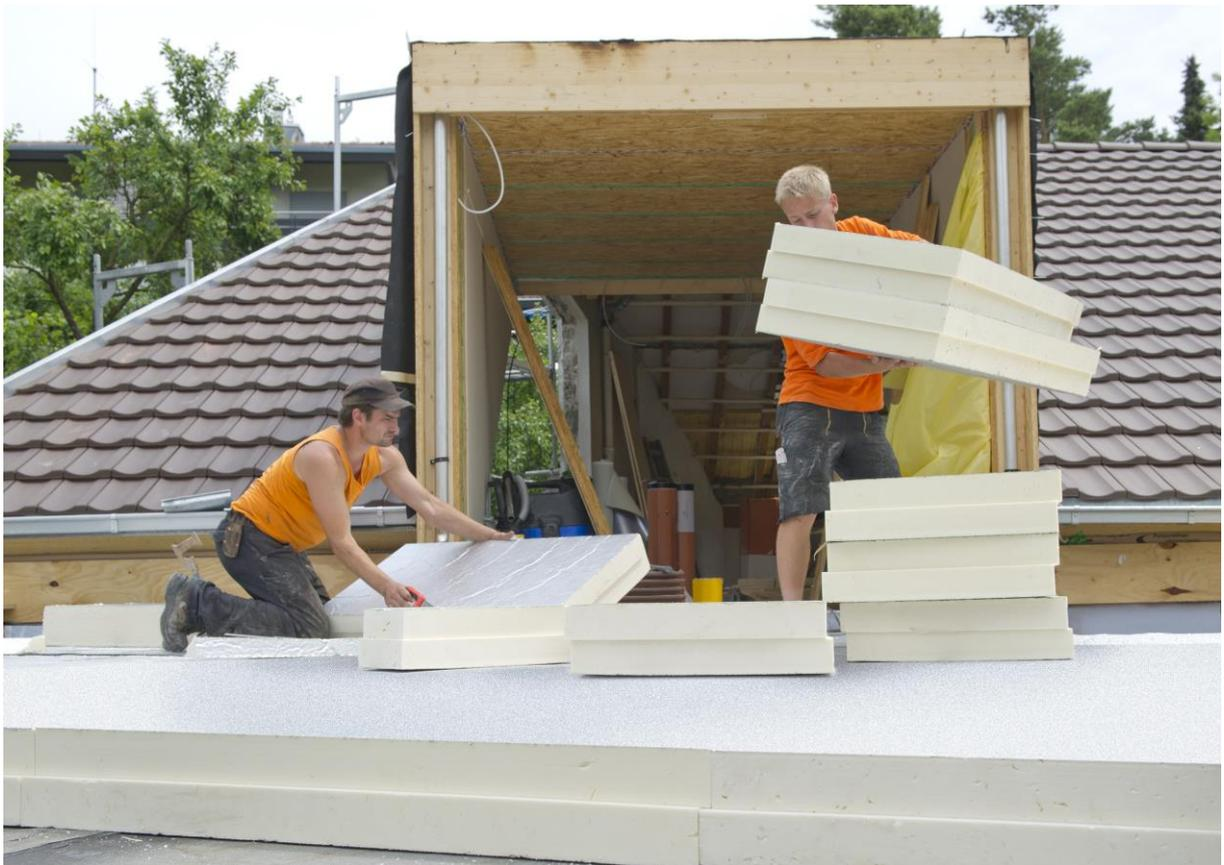
Eine Dachterrasse kann grundsätzlich auf dem Flachdach oder einem Garagendach, aber auch auf einer massiven Balkonüberdachung gebaut werden. Hoch bis sehr hoch druckbelastbare PU-Dämmelemente sind während des gesamten Lebenszyklus einer Dachterrasse funktionstüchtig.
