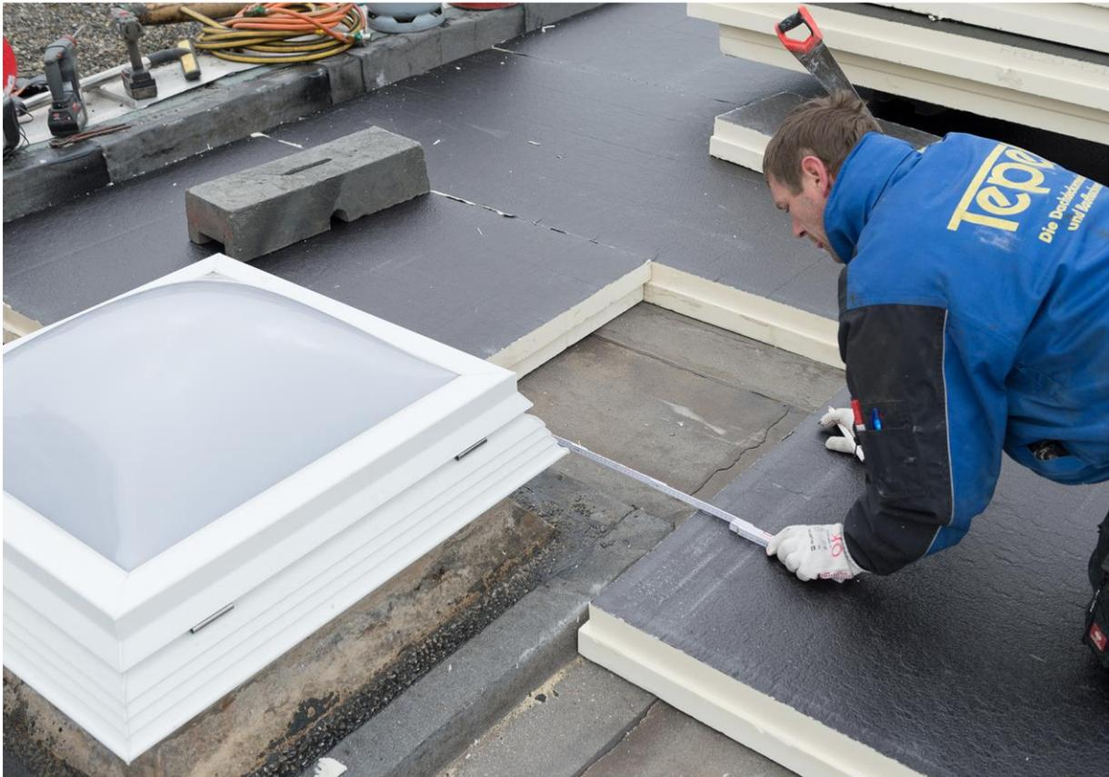
PU-Dämmstoffe haben eine sehr geringe Wärmeleitfähigkeit. Bei einer Flachdachsanie rung ermöglichen sie niedrige und druckfeste Dachaufbauten.
