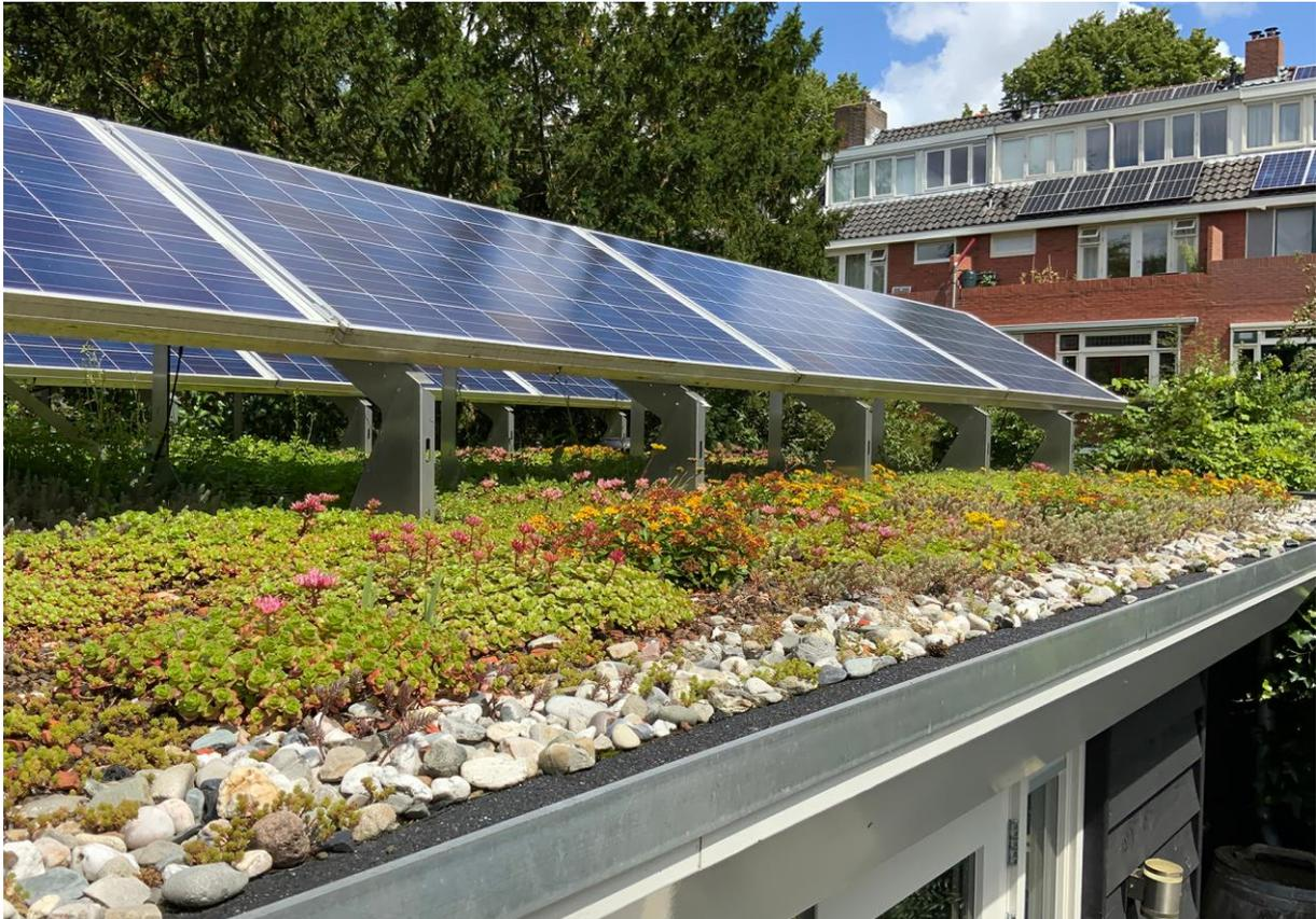
Für eine Kombination von Photovoltaik und Dachbegrünung ist das Flachdach ideal. Robuste, niedrigwachsende Pflanzen sorgen für einen kühlenden Effekt und schirmen vor UV-Strahlung ab.
