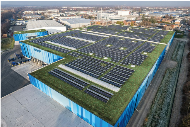
Großflächiges Flachdach in Stahlleichtbauweise mit Dachbegrünung und Photovoltaikanlage (Foto: Paul Bauder GmbH & Co. KG)
